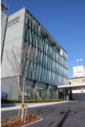
向日市役所 新庁舎
