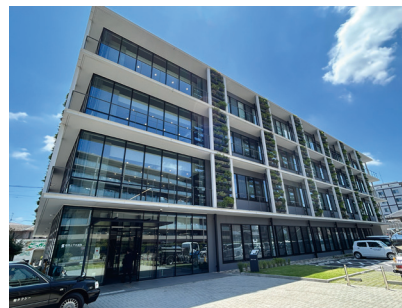
上下水道局庁舎…屋外には応急給水栓、耐震性貯水槽、防災広場が整備され、外部からの復旧支援の受入れを視野に入れたレイアウトとなっている（本会撮影）
