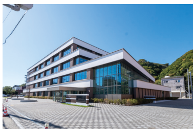
稚内市役所新庁舎 (写真提供=稚内市)
