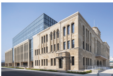
会津若松市役所新庁舎 （写真提供＝会津若松市）
