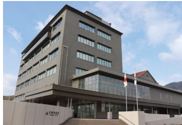
竹原市役所新庁舎 (写真提供＝竹原市)
