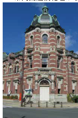
国指定重要文化財の岩手銀行赤レンガ館(明治44年建設)
