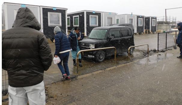
建設が進む輪島市内の仮設住宅(輪島市)
