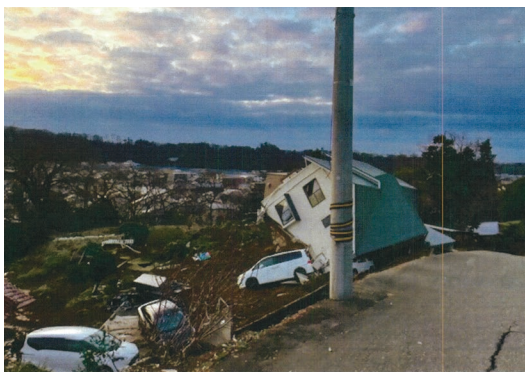
田上新町で崖崩れが発生し、住宅4棟が全壊した(金沢市)
