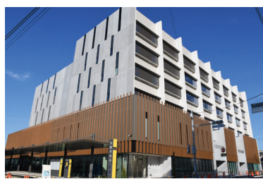
糸島市役所新庁舎 (写真提供=糸島市)
