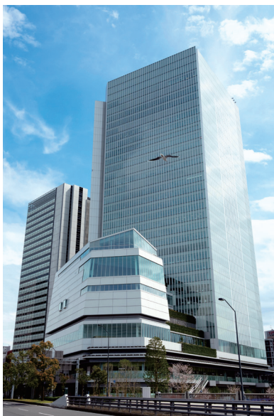
横浜市新庁舎（手前部分が議事堂）
