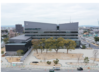
八代市役所新庁舎 (写真提供＝八代市)
