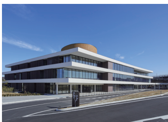
常滑市役所新庁舎 (写真提供=常滑市)
