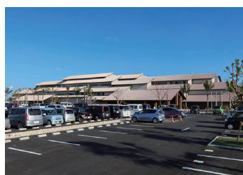
石垣市役所新庁舎 (写真提供=石垣市)
