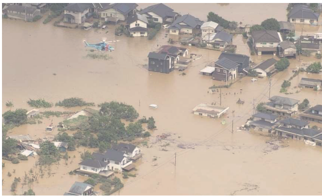
発災直後の人吉市内の様子（国土交通省九州地方整備局提供）
