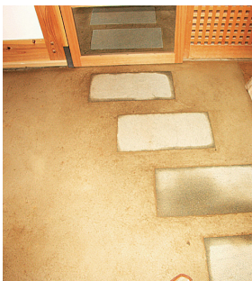
三和土と呼ばれる土間は室内湿度を整え、快適な住環境を提供(上) エコハウスは釘などの金物に頼らず木組みで建設されており、伝統の技が光る(下)
