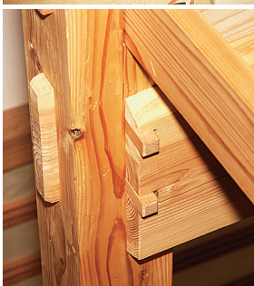
三和土と呼ばれる土間は室内湿度を整え、快適な住環境を提供(上) エコハウスは釘などの金物に頼らず木組みで建設されており、伝統の技が光る(下)
