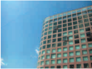
第1期工事が完了し、業務を開始した新庁舎
