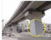
橋脚の耐震補強
