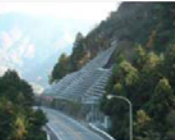
斜面崩落防止対策
