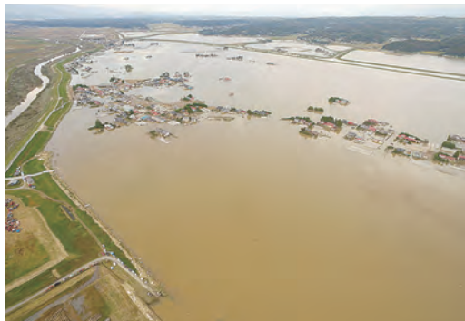
浸水した鹿島台地域 (宮城県提供写真)
