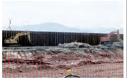
千曲川破堤箇所 に設けられた 鋼矢板仮締切堤防
