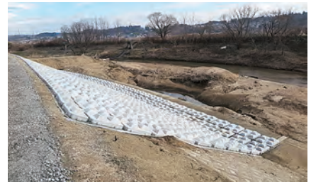
谷田川決壊箇所(郡山市)
