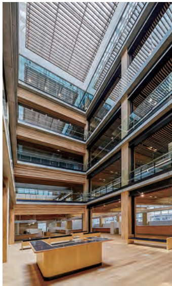
梁、柱に木材を使用した吹き抜け (写真=長門市提供)
