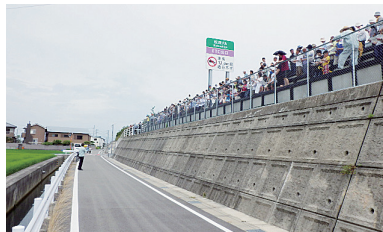
高速道路の法面を利用した津波避難施設(市民対象の説明会)【提供=徳島市】
