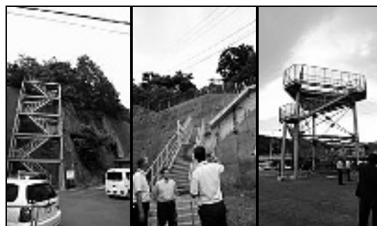
急傾斜地のための津波避難階段及び津波避難タワー（静岡県沼津市）
