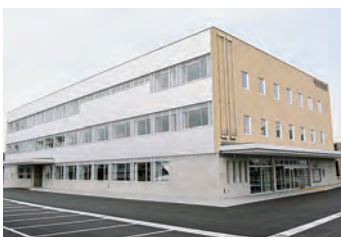
尾花沢市役所新庁舎 【写真提供=尾花沢市】
