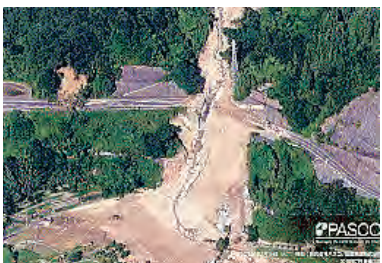
被災した国道375号線 【提供=呉市】
