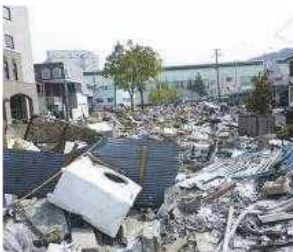
2011.4 津波被害の直後
